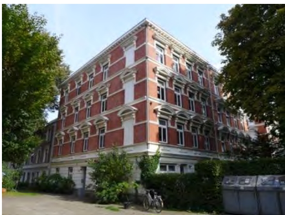
Abb. 18: Kopfgebäude Falkenried-Terrassen aus der Gründerzeit
